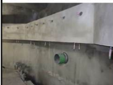
防水前の工事
