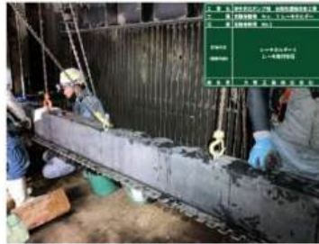
取替している所
